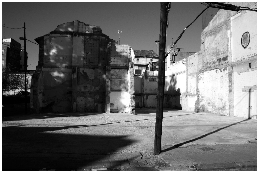
FIGURA 5.—Solar del Horno La Estrella (calle Escalante), derribado en abril del 2009. El edificio disponía de una típica torre-miramar del Cabanyal. 2010. Fotografía: Beatriz Santamarina.
