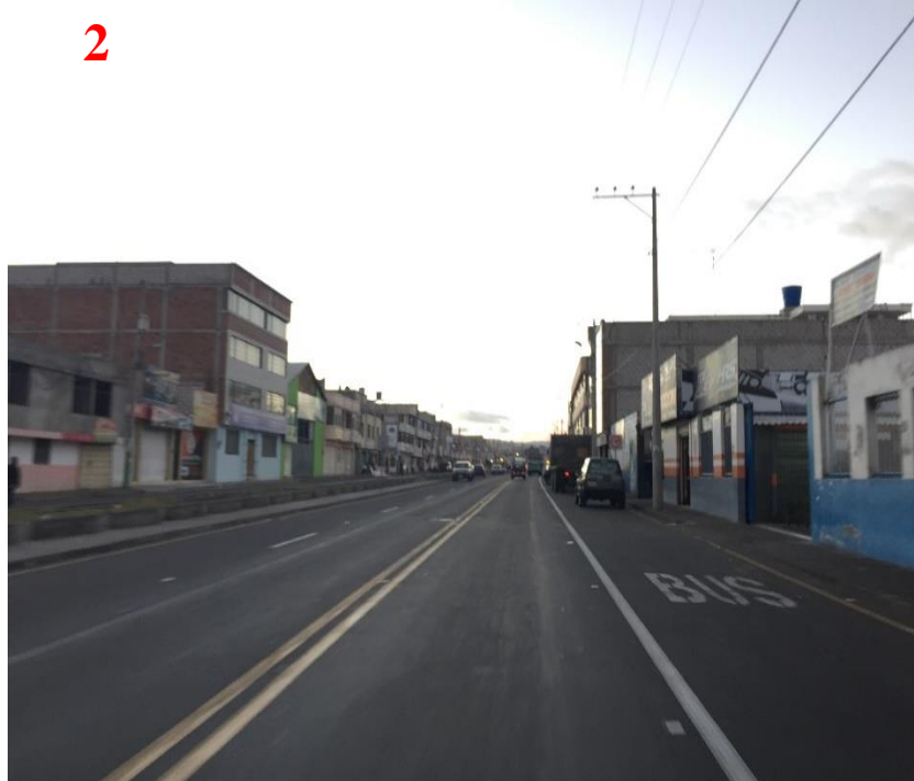
Imagen 36: Av. Marco Aurelio Subía – cuatro carriles una exclusiva para bus
