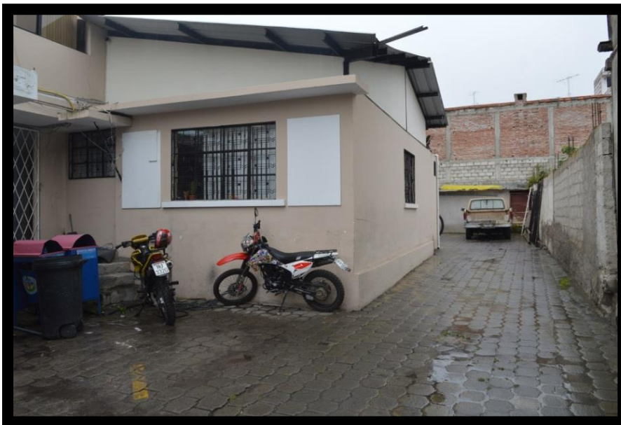
Fotografía 11 Bloque Nuevo Departamento Financiero
