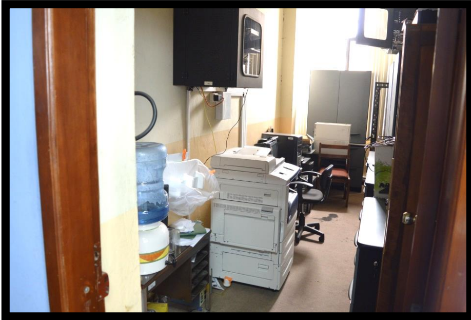
Fotografía 7 cuarto de racks
