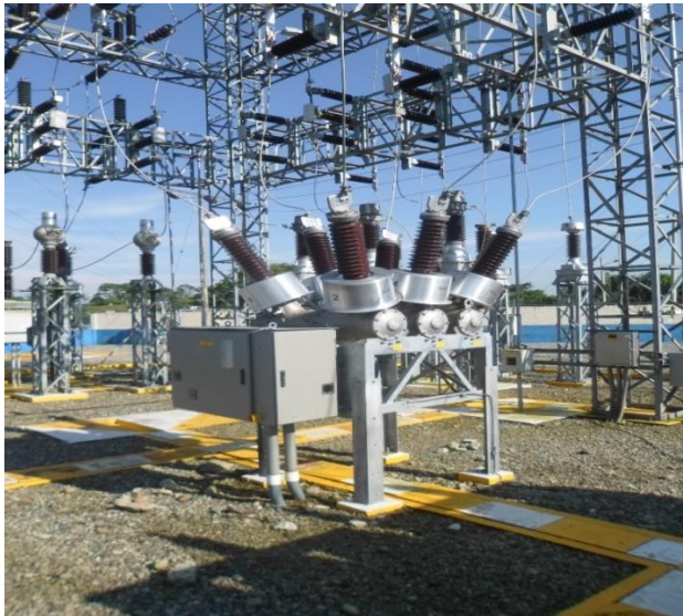
Figura N° 4: Interruptor de potencia 69 KV
