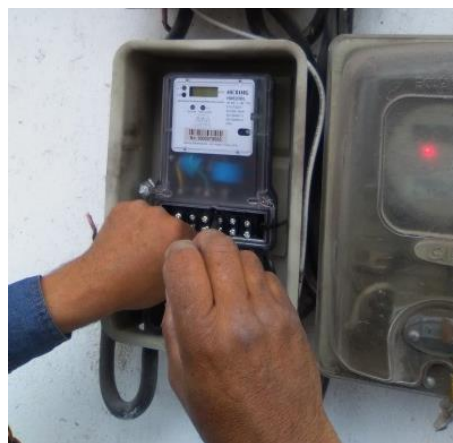
Figura 18: Reajuste de contactos en el medidor
