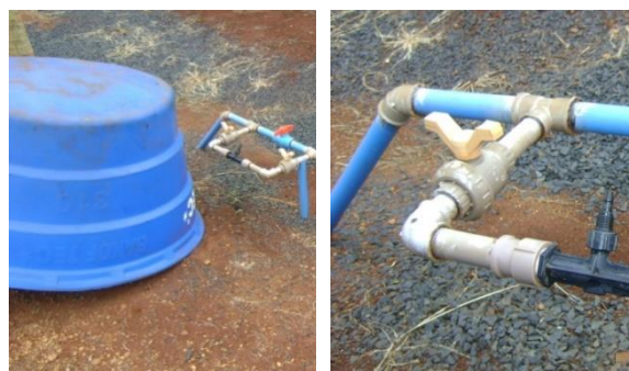
Figura 10. Malha hidráulica do sistema de irrigação por gotejamento subsuperficial.
