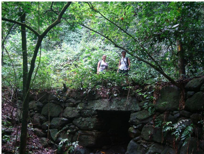
Figura 09. Antiguo puente de piedra en el Maciço da Tijuca (RJ)
