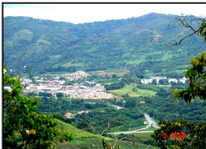
FUGURA No. 4-2: PANORÁMICA DE PUENTE NACIONAL
