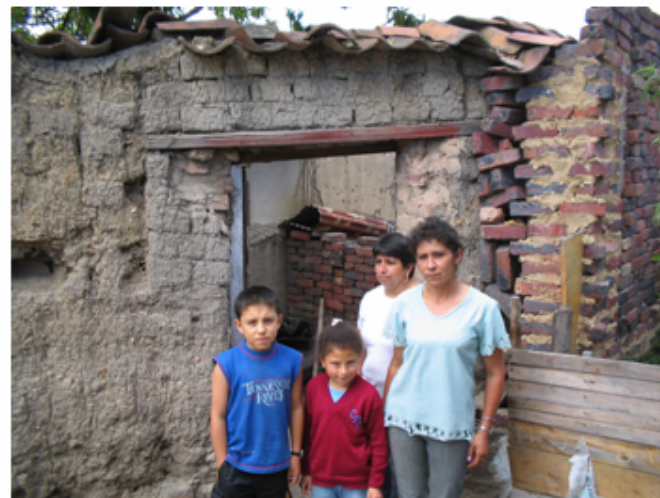
FAMILIA VISITADA PARA MEJORAMIENTO DE VIVIENDA BARRIO MOCHACA
