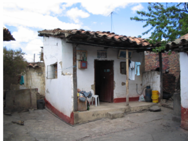
FOTO DE VIVIENDA VISITADA PARA VIVIENDA NUEVA BARRIO MOCHACA
