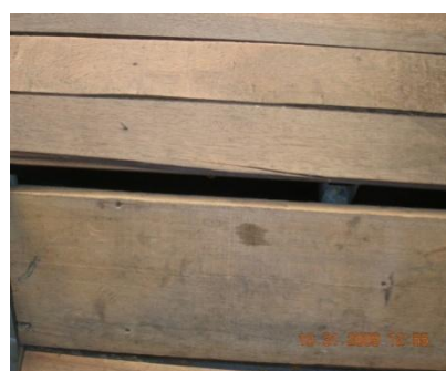
Escaleras tercer piso Industrias Argos Ltda.
