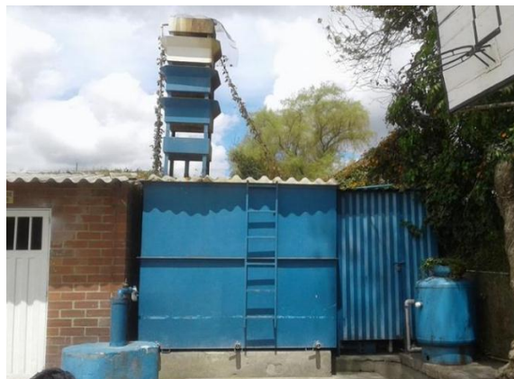
Imagen 1. Estado inicial de la PTAP
