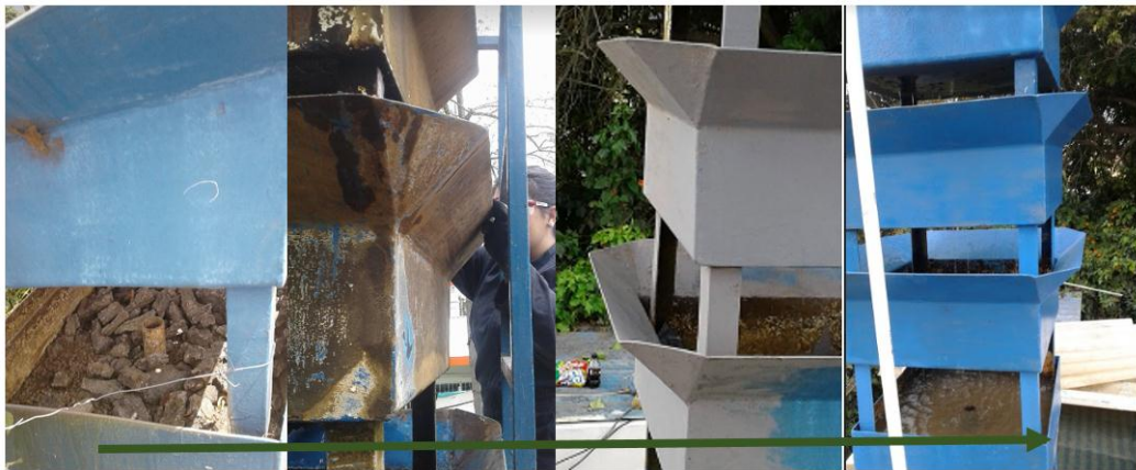
Imagen 2. De izquierda a derecha se evidencia el antes y el después del proceso de mantenimiento de las bandejas
