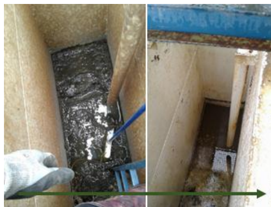
Imagen 3. De izquierda a derecha se evidencia el antes y el después, del mantenimiento del tanque de coagulación y floculación.
