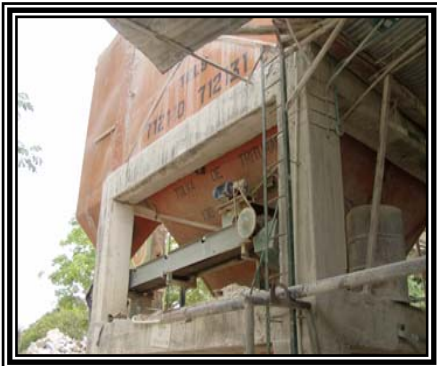
Punto 8 Cinagro: Generación de MP en el proceso triturado y molienda de la roca.
