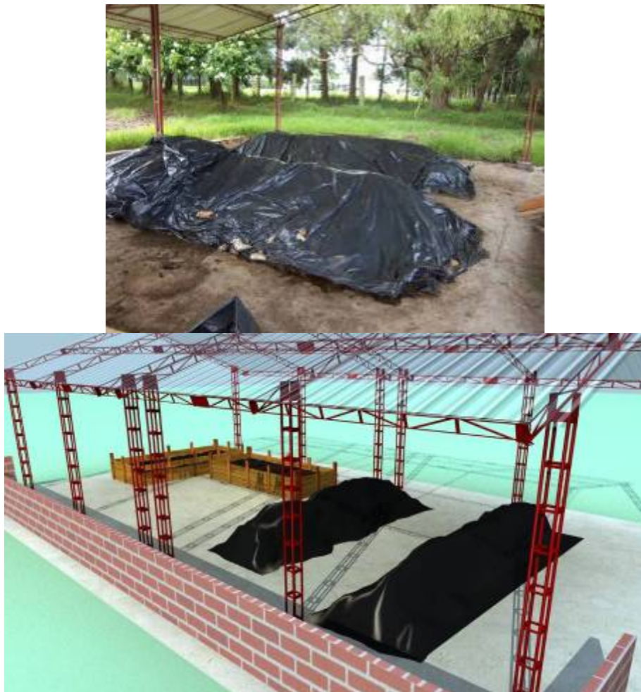
Figura 31. Pilas de compostaje
