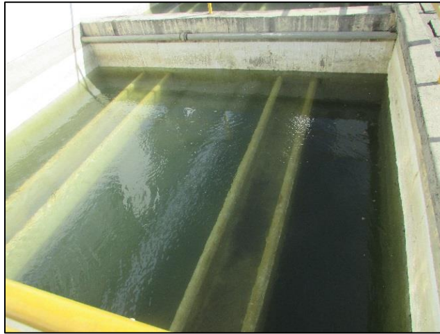
Imagen 7. Unidades de filtración de la PTAP Fuentes: Autores.
