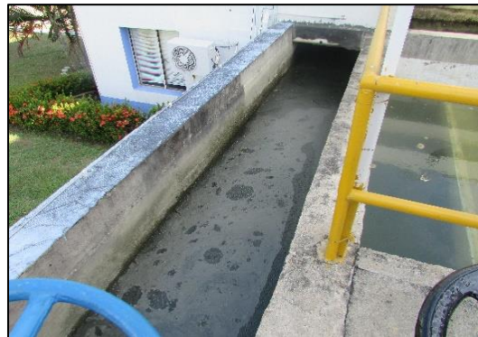
Imagen 11. Agua en proceso de tratamiento Fuente: Autores.
