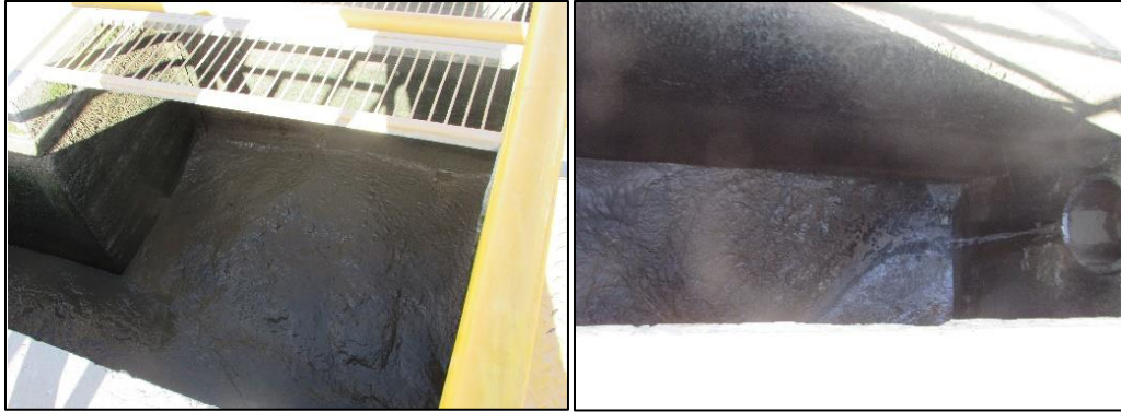
Imagen 12. Salida de lodos después del lavado
