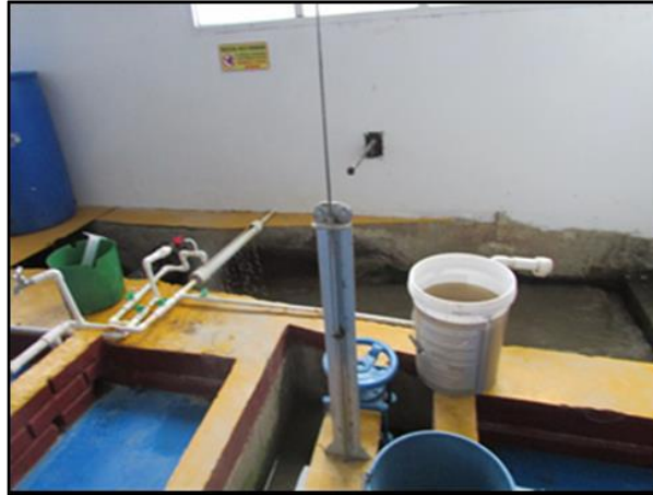
Imagen 4. Regleta para medición de caudal de recibo del agua del Distrito de riego Fuente: Autores.
