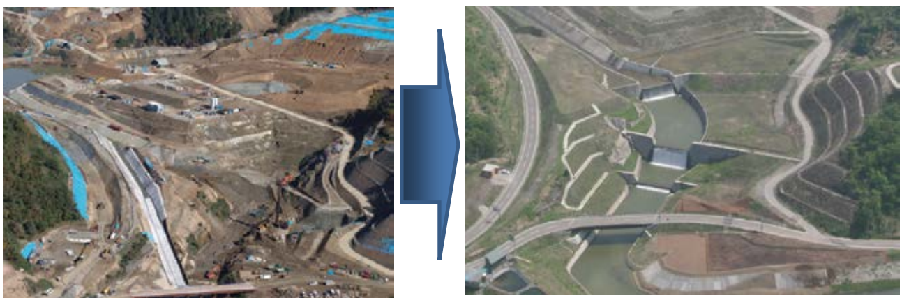
写真1 2004年新潟県中越地震で発生した天然ダム(東竹沢地区)における対策状況(左; 2005年, 右; 2006年)
