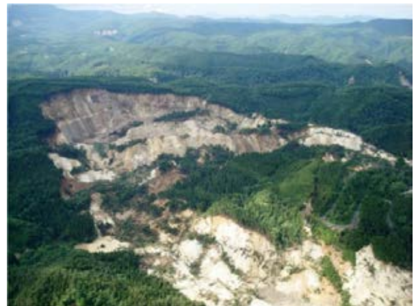
図1 荒砥沢ダム上流部地すべり
