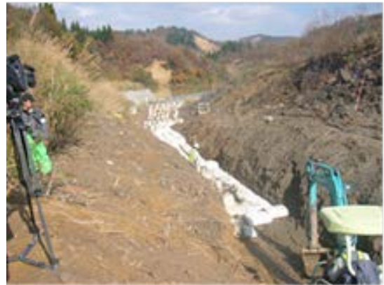
写真1 芋川(東竹沢)緊急排水路工事状況
