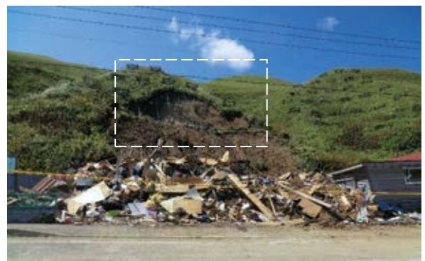
写真4 海食崖中部から抜け落ちた土塊が住宅を押しつぶす(白枠は写真3の範囲)
