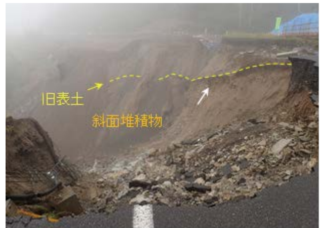
写真8 日勝峠7合目崩壊地の斜面堆積物 クロボク直下の赤褐色テフラは9,000年前降灰
