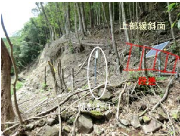
写真5 傾斜計①を設置したブロック Photo 5 Small landslide mass with tilt meter ①.
