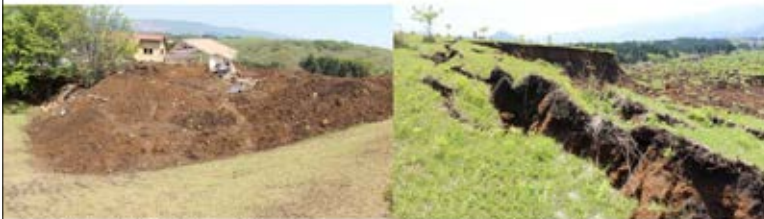
住宅地まで到達した地すべりロープ
