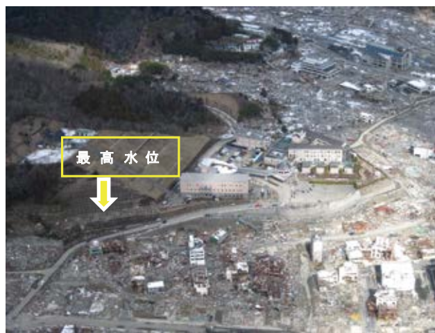
写真3 宮城県女川町堀切山特定利用斜面保全事業箇所(2011年3月)
