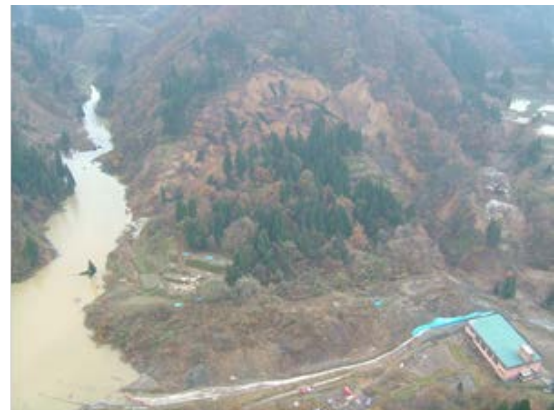
写真2 東竹沢緊急対策工事完了(H16.11.6)
