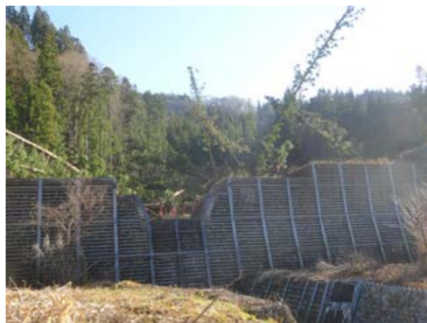
写真1 地震により発生した，泥流化した地滑り土塊を止めた砂防えん堤
