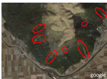
平成24年豪雨時の土砂災害発生箇所
