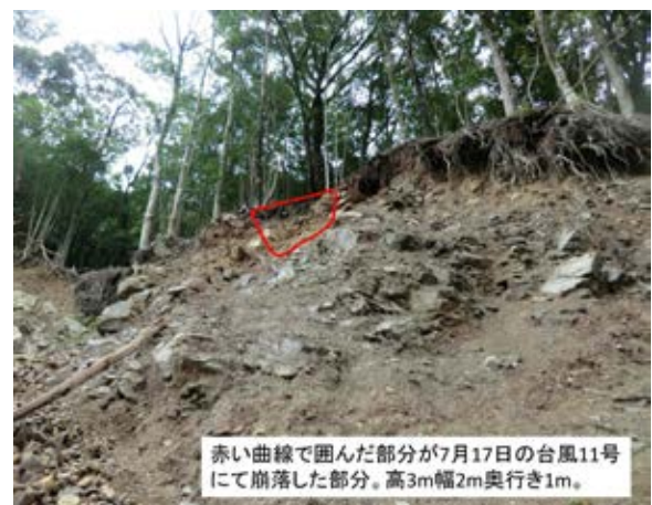
写真6 崩落した滑落崖上の小ブロック Photo 6 Small soil mass on the head scarp.
