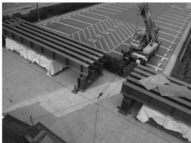
図3.4.2 曳家で用いたラフテレーンクレーン
