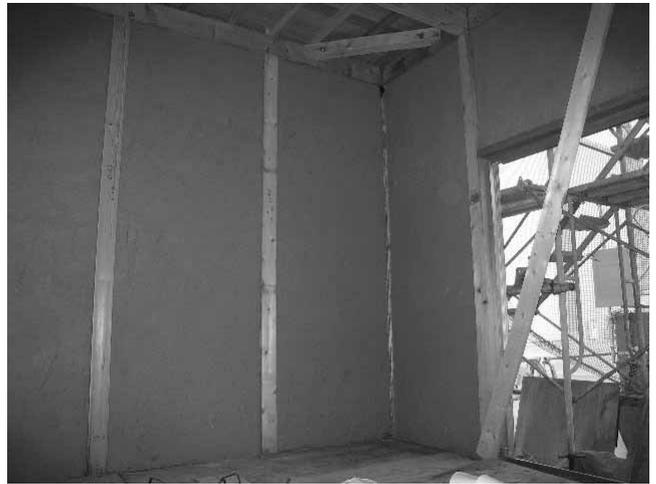
図 3.3.10 荒壁施工後の C 棟 1 階
