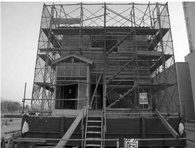
図 3.3.17 野地板施工後の D 棟外観
