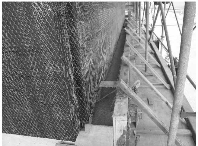
図 3.3.18 あと施工アンカーのコンクリート打設 (D 棟)
