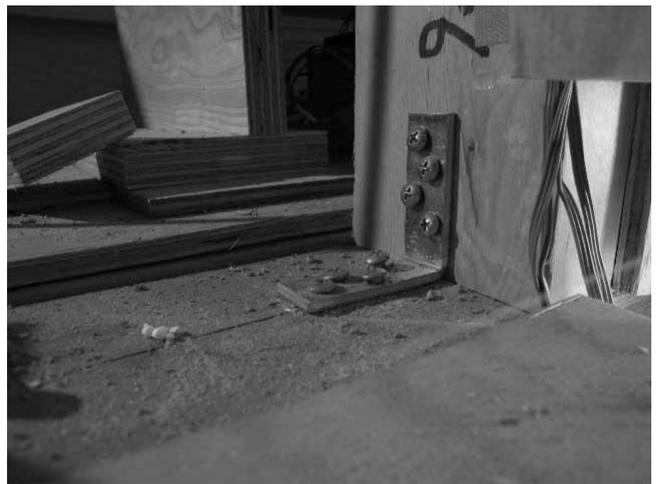
図 3.5.33 C 棟柱脚引き抜け
