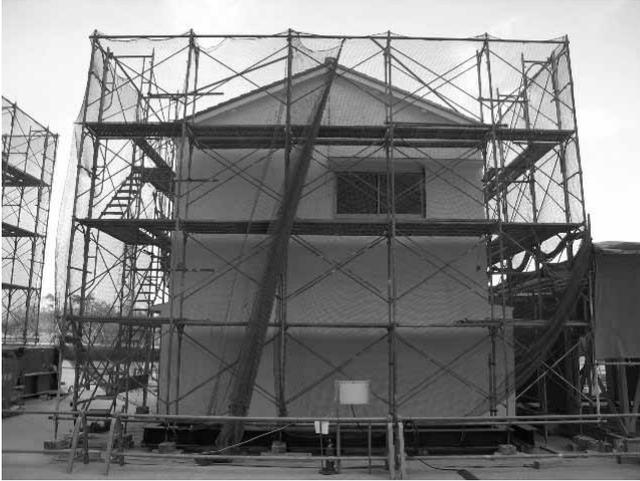
図 3.3.25 リシン仕上げおよび塗装後の C 棟外観
