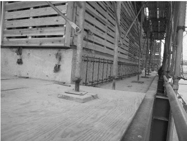
図 3.3.15 あと施工アンカー鉄筋の様子 (D 棟)
