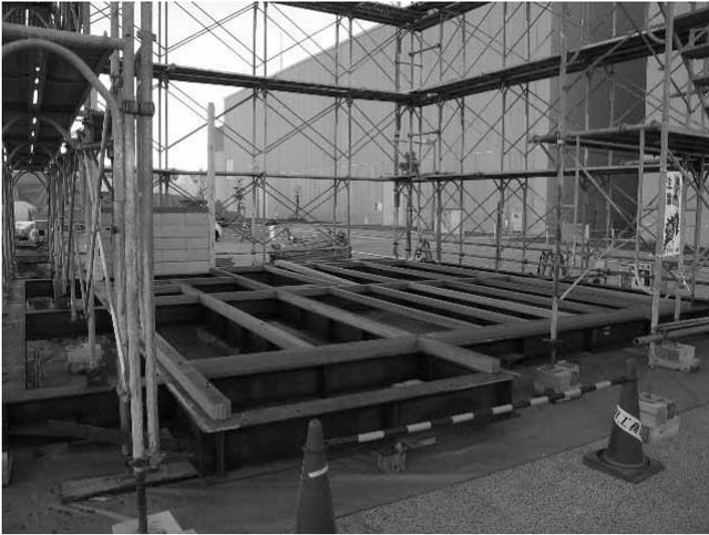
図 3.3.1 C 棟の鉄骨架台
