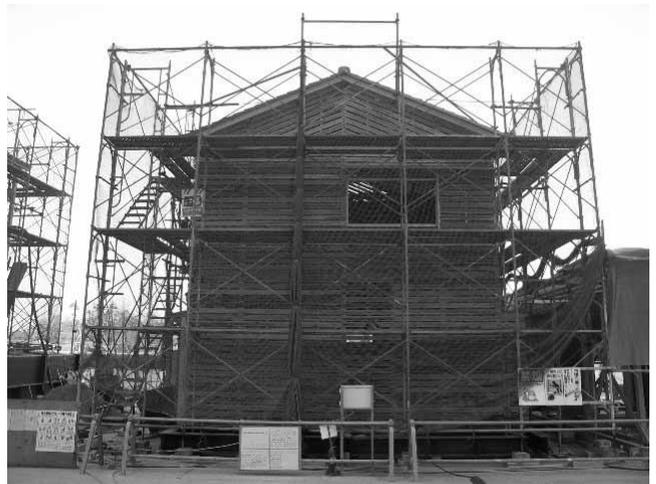
図 3.3.16 野地板施工後の C 棟外観 (C 棟)
