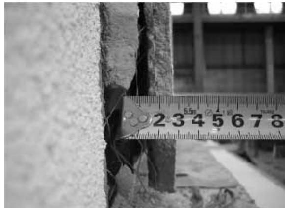
図 3.5.27 D 棟外壁モルタルの浮き上がり
