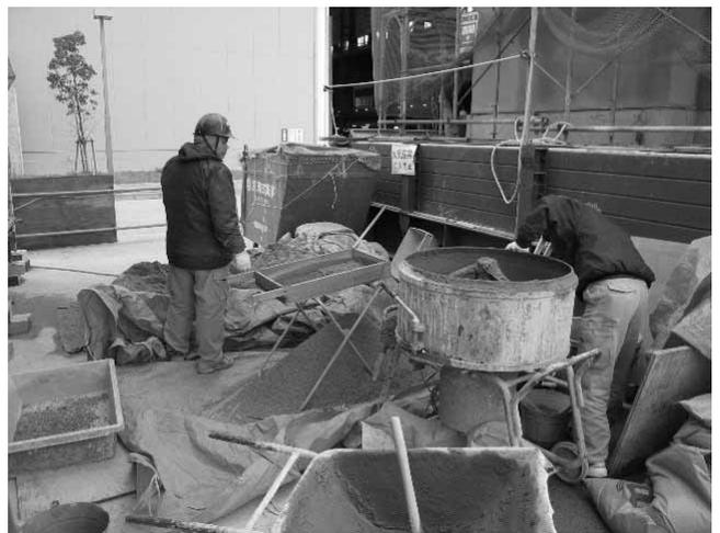
図 3.3.24 外壁モルタルのリシン仕上げの調合
