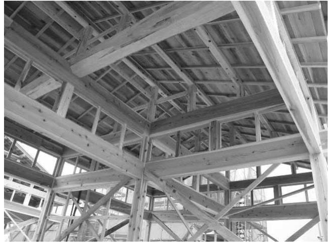
図2.2.30 S試験体の軸組 (荒壁パネルなし)
