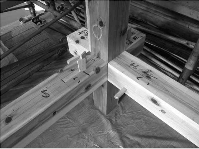
図2.2.13 標準試験体足固め仕様の接合部
