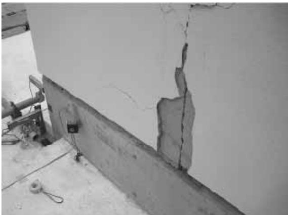
図 3.5.26 D 棟外壁モルタル損傷拡大
