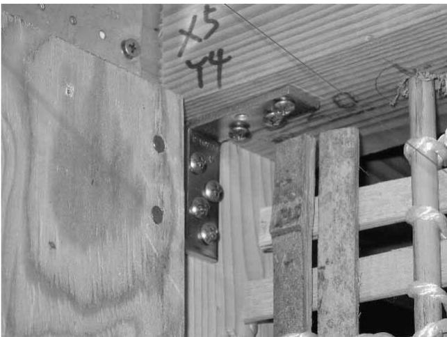
図 3.5.32 C 棟柱頭引き抜け
