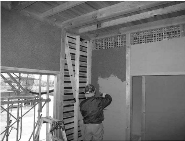
図 3.3.21 内壁仕上げ塗りの様子 (D 棟)
