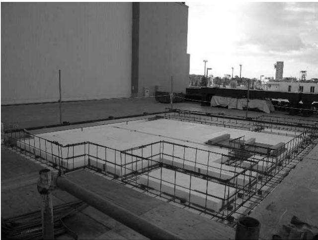
図 3.3.3 D 棟の模擬地盤とコンクリート基礎部の鉄筋
