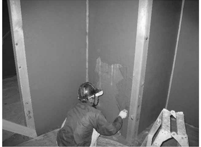
図 3.3.14 中塗り壁の施工 (C 棟)
