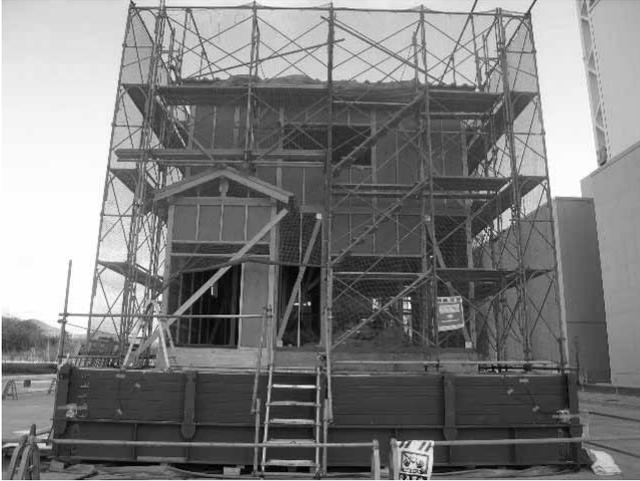
図 3.3.13 荒壁施工後の D 棟外観
