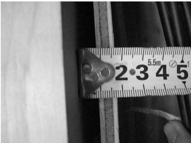
図 3.5.29 D 棟内壁合板の浮き上がり
