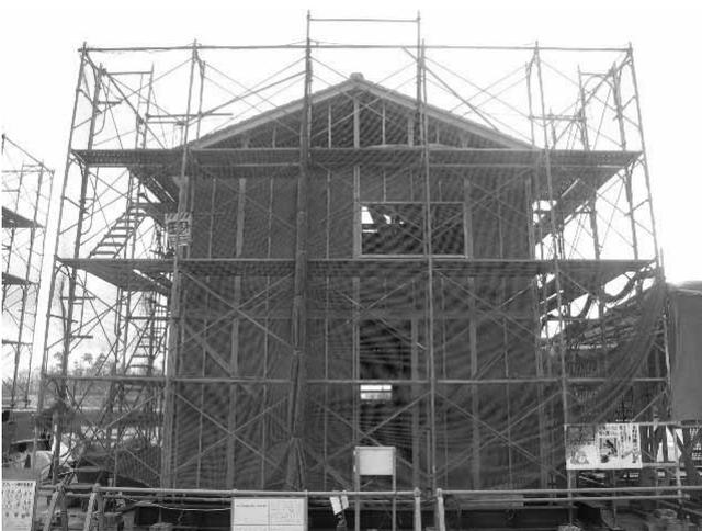
図 3.3.11 荒壁施工後の C 棟外観
