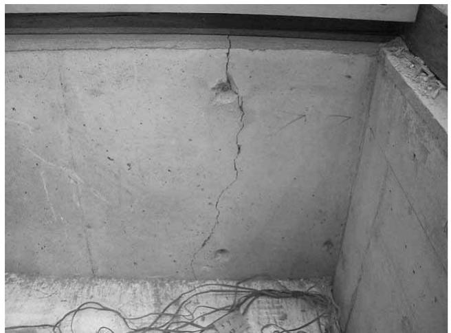
図 3.5.35 D 棟基礎の損傷
