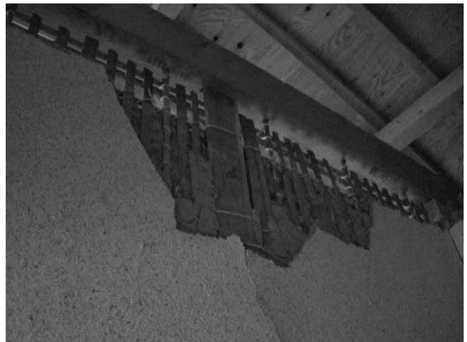
図 3.5.30 D 棟内壁土壁の剥落
