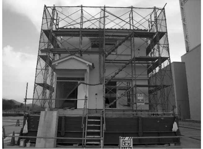
図 3.3.26 リシン仕上げおよび塗装後の D 棟外観
