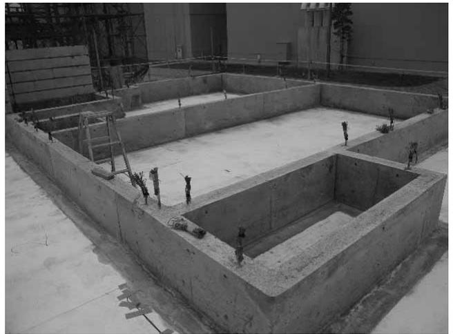
図 3.3.4 D 棟の模擬地盤とコンクリート基礎
