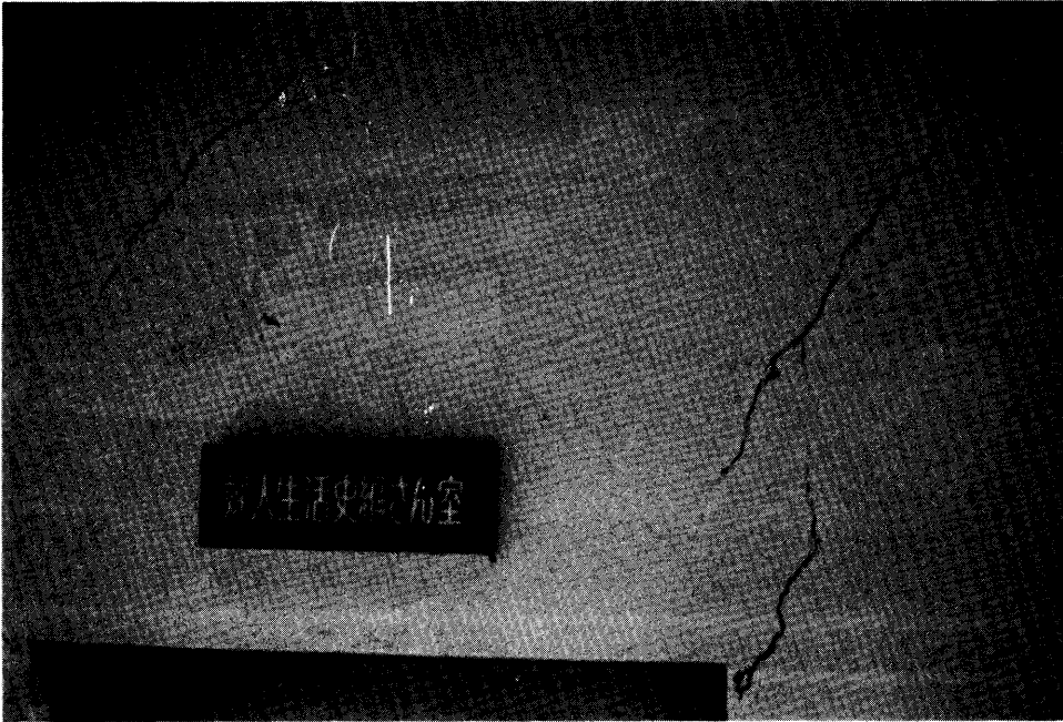
写真 4.1 秋田県庁 2 階男子トイレ右横の階段の壁
