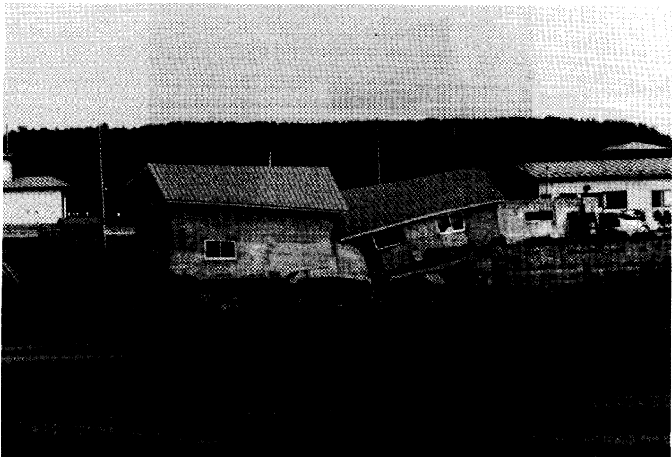
写真 4.23 能代市臈沢付近の民家の破損 住居か物置かはっきりしない. 典型的な盛土被害.
