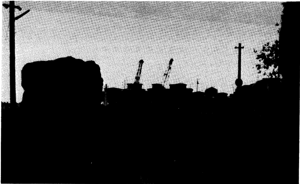
写真 4.44 秋田県山本郡八森町付近 国道 101 号に落ちた石. 人的被害等はなかったよう.
