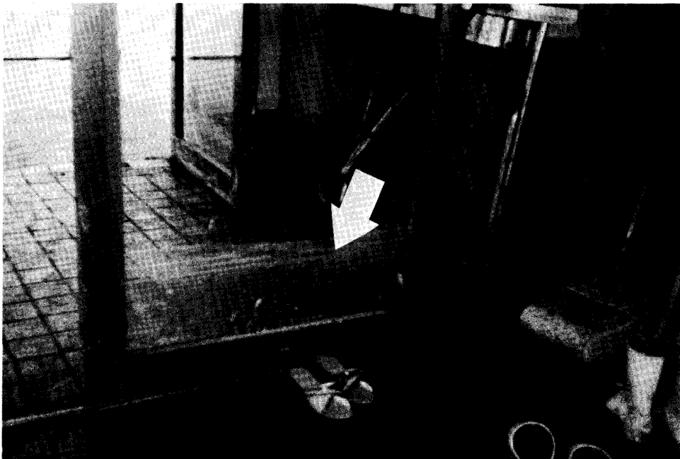
写真 5.10 サニーランド入口ガラスドについての津波痕跡, 5月30日11時30分撮影.
