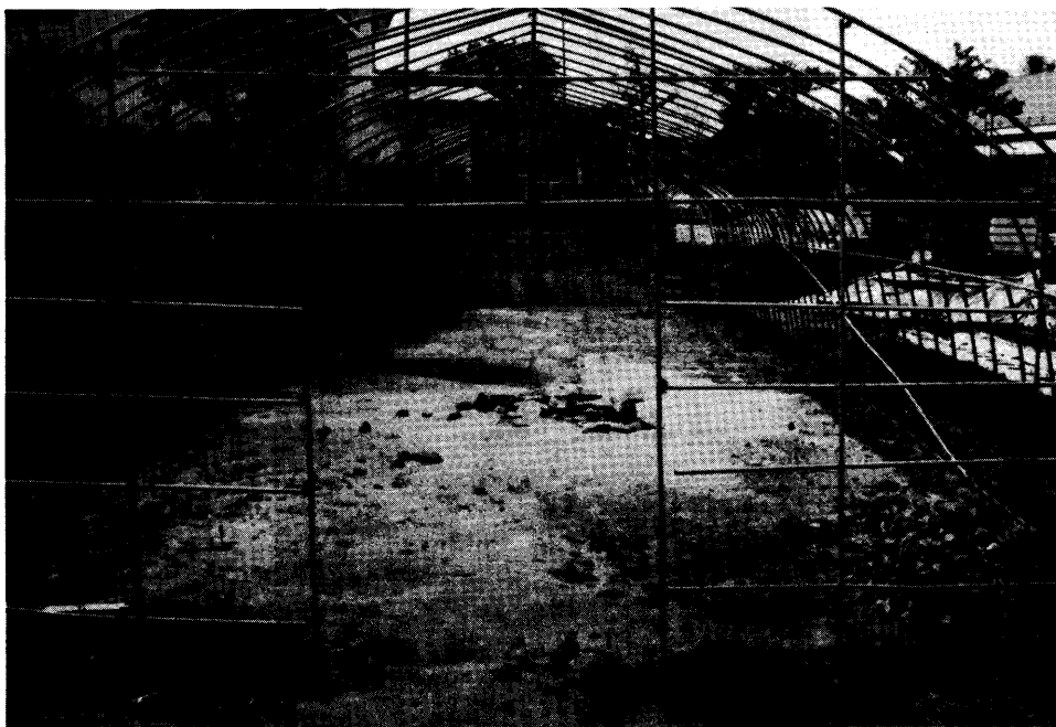
写真 4.55 青森県車力村 ハウス内に発生した噴砂跡.
