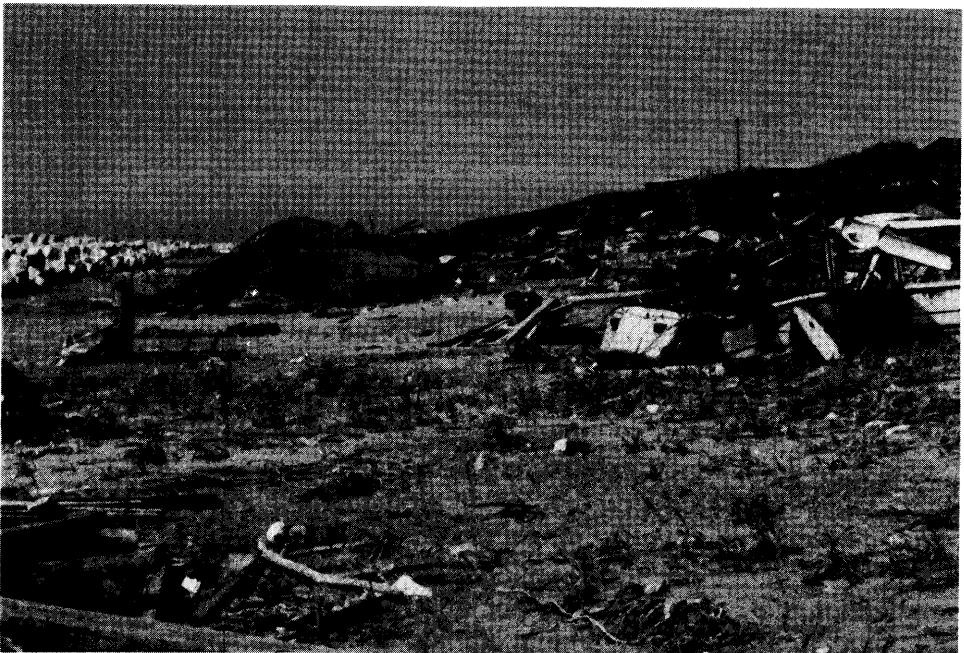
写真 5.8 八竜町釜谷の倒壊家屋，6月15日13時撮影．
