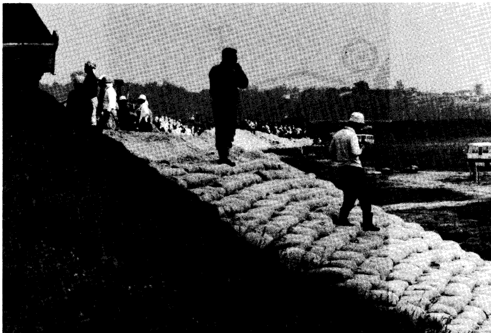
写真 4.48 青森県車力村下車力付近 堤防復旧工事の様様.
