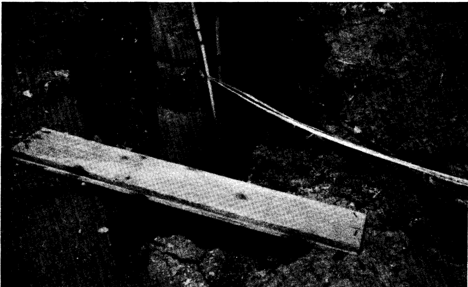
写真 4.54 青森県車力村富范小学校 電柱の根元から噴砂。
