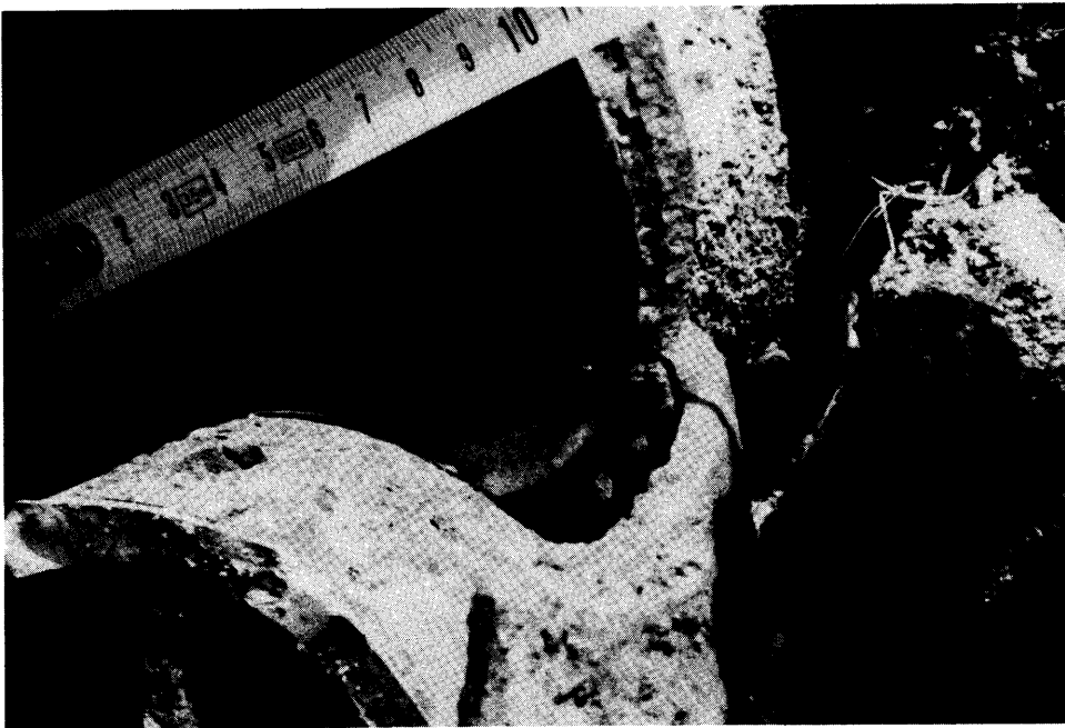
写真 4.26 能代温泉近くの丸メホテル前の水道管被害 管とバルブのジョイント部. 管端部に変形を生じている.
