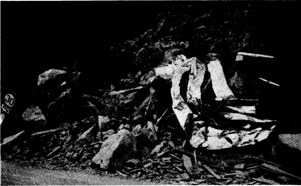
写真 4. 45 青森県山本郡八森町岩館の落石 切取り斜面の上部が落下.
