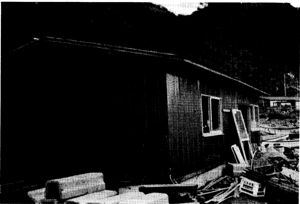
写真 5.30 岩崎村木蓮寺，蝦名理三氏所有小屋。津波で破損している。この南隣りにあった佃煮工場は完全流失した。5月30日17時頃撮影。
