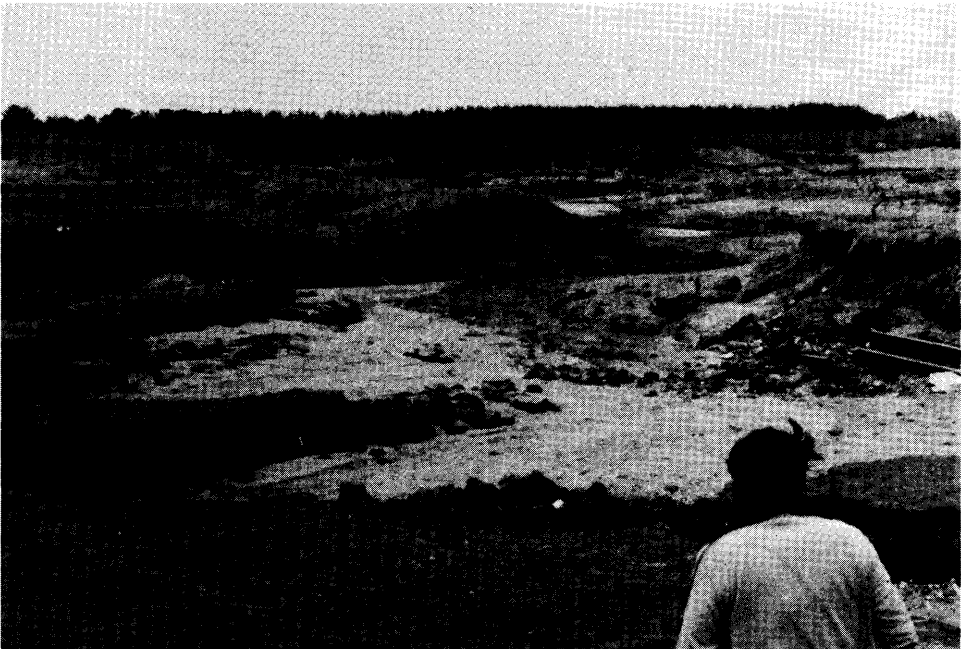
写真 5.24 上の写真の農道をまっすぐ進んで埧川河口の土堤にぶつかった地点，戻り潮による田と土堤の侵食が著しい．6 月 15 日 11 時ごろ撮影．
