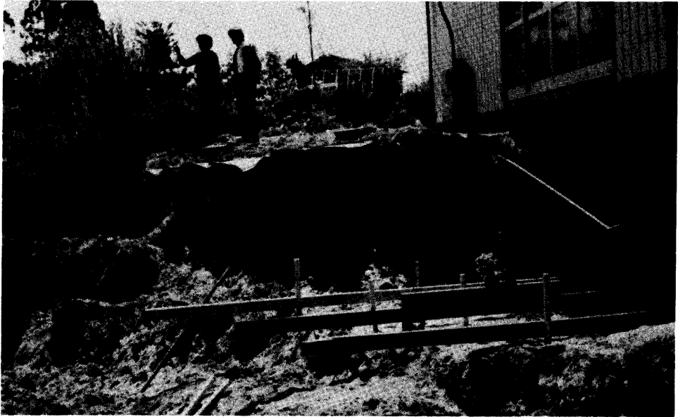
写真 4.11 男鹿市滝川地区 沢を埋めた地盤が崩れ、基礎が消失.
