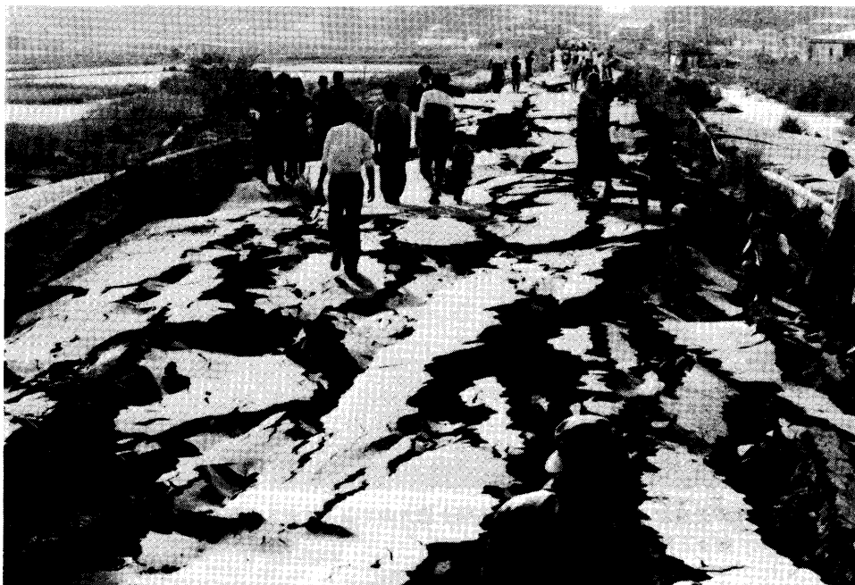
写真 4.19 大瀧村五明光橋 五明光側. 壊れ方は八郎瀧側よりひどい. 日曜日のせいか見物客も多い.
