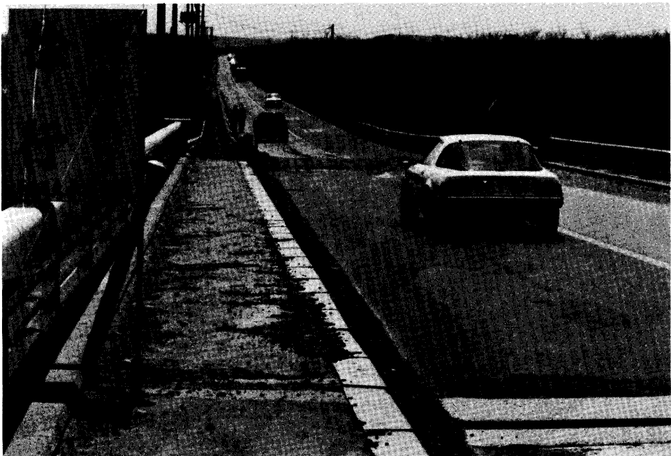
写真 4.8 男鹿大橋 橋上から秋田側を見る.
