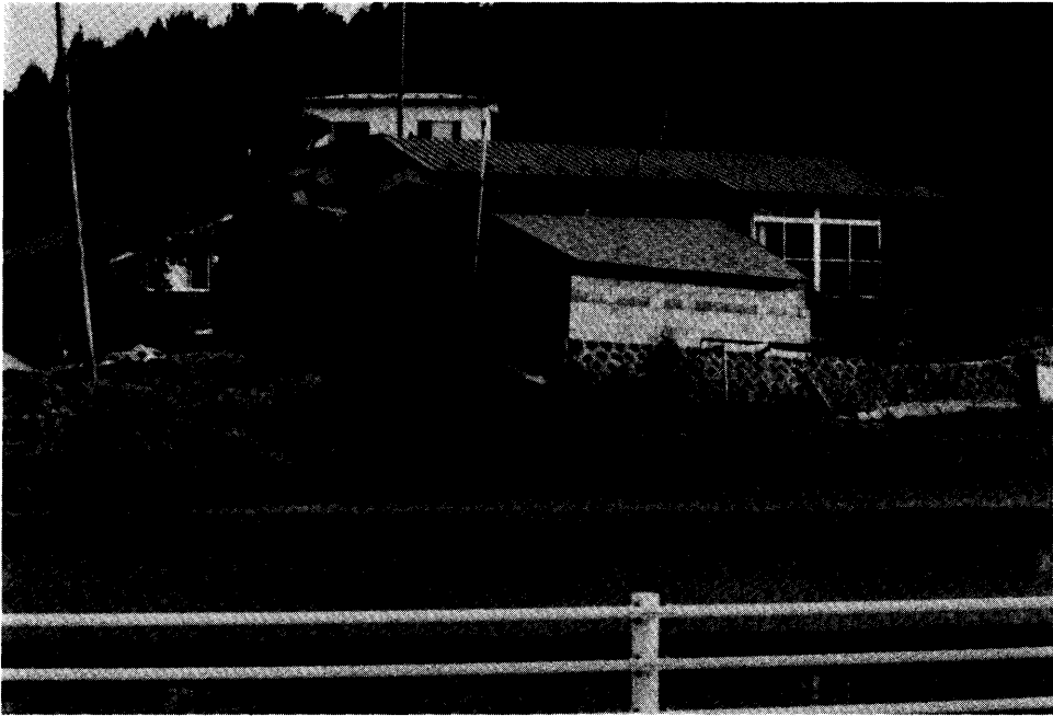
写真 4.3 男鹿市打ヶ崎付近, 船川街道沿いで少し秋田方向寄りに行ったところ(脇本のあたりか). 盛土がずって物置小屋が破損.
