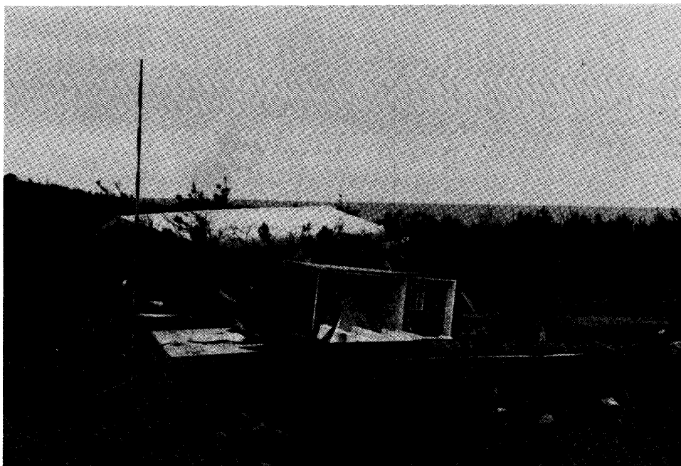
写真 5.15 峰浜村水沢海岸の流失家屋。6月15日11時10分撮影。
