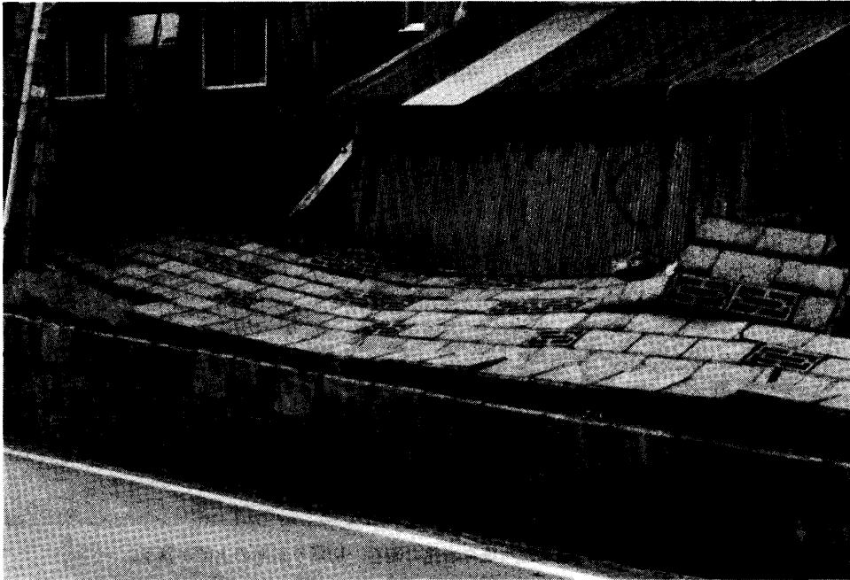
写真 4.47 青森県西津軽郡鯨ヶ沢町付近 ブロック塀の転倒.
