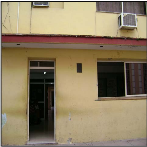
Figura 1. Antigua dispensario de la Brigada 17, sito en la calle Luis Estévez No 163
