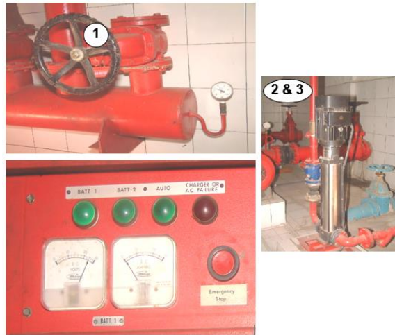
Gambar 1. Perawatan harian rumah pompa (Dokumentasi, 2018)
