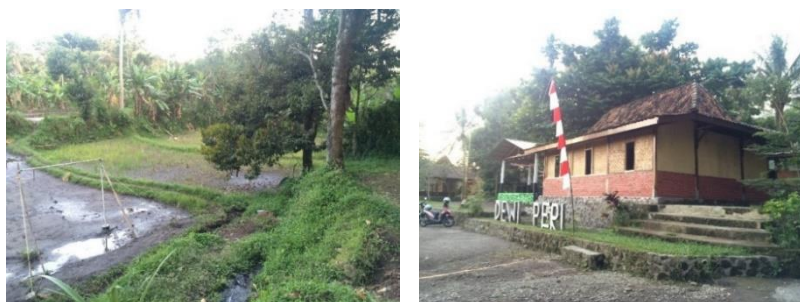
Sumber: Dokumentasi Penulis, 2016
