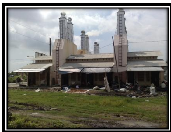
Gambar 2. Kondisi eksisting bangunan mitra
