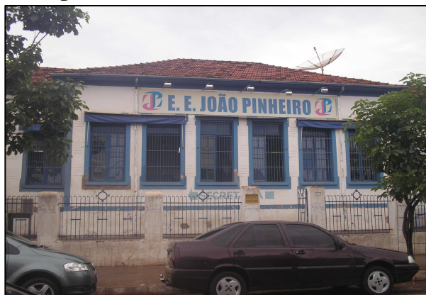
Imagem 2 – Fachada da Escola João Pinheiro
