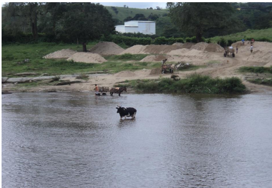
Figura 11: Dragagem no rio Paraíba do Meio. Fonte: Acervo dos autores, 2012.
