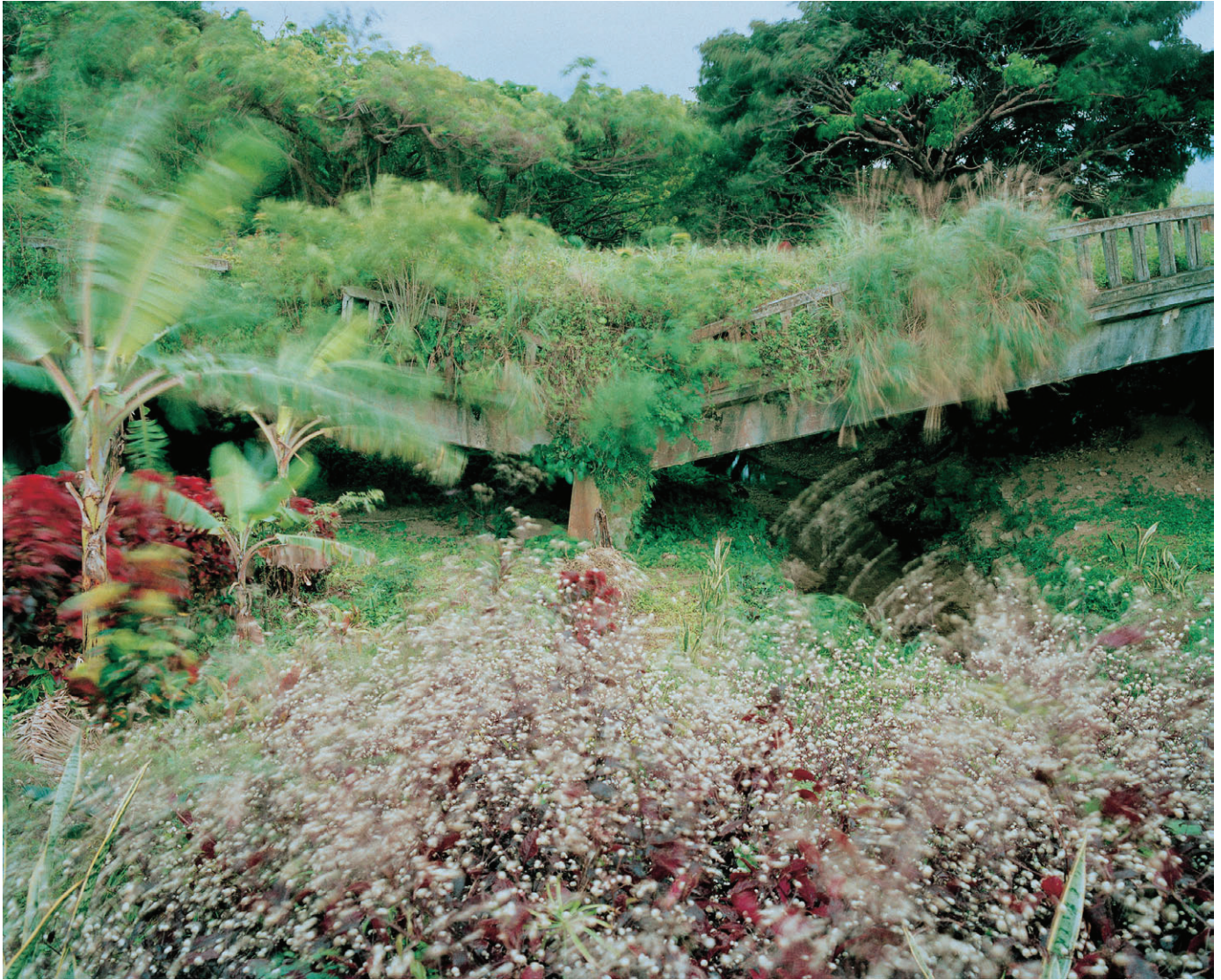
旧天願橋 地元の人が「アメリカ軍が爆撃した橋」と教えてくれたが、後に調べてみると旧日本軍が米軍阻止の目的で自ら爆撃していた。沖縄
