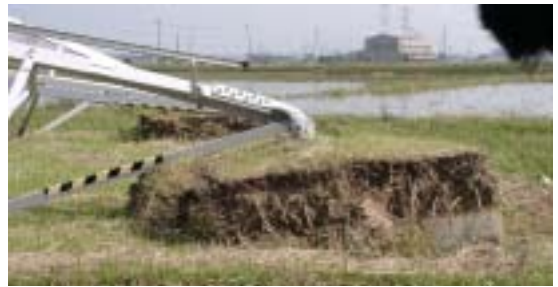
写真 6 香取線 22号鉄塔基部
