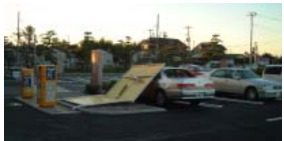
写真 15 鹿島セントラルビル駐車場の被害状況
