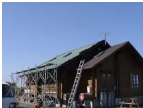
写真 28 スレート瓦が片面のみ剥がれる被害壁， 窓には飛散物衝突跡がみられる
