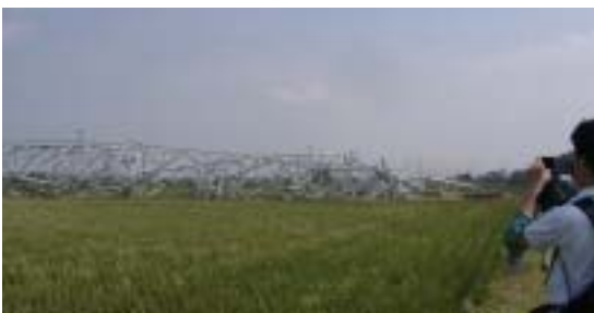
写真 5 香取線 22号鉄塔
