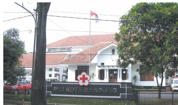
Gambar II. 1. Gedung PMI Kota Bandung
