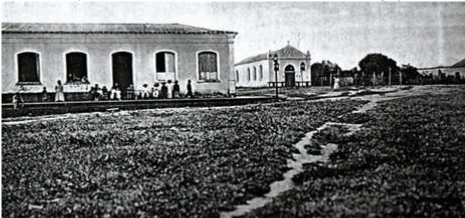
Figura 07: Foto do prédio da sede da fazenda Boa Vista e ao fundo a igreja matriz em 1905
