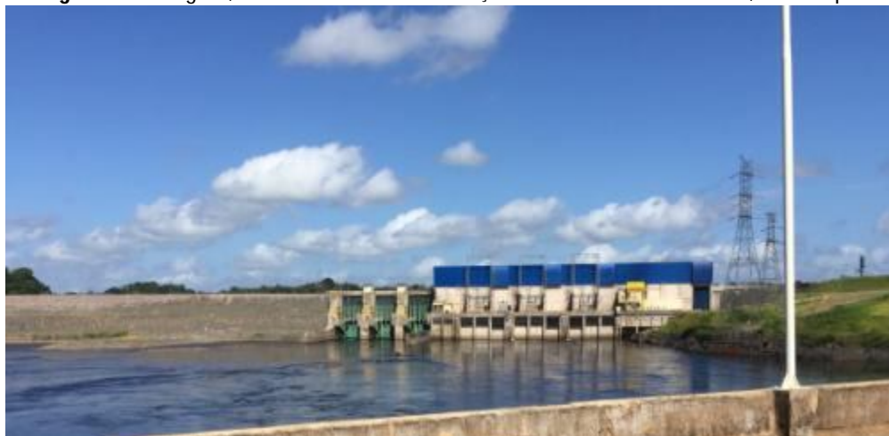
Figura 7: Barragem, vertedouro e casa de Força da UHE – Ferreira Gomes, no Amapá
