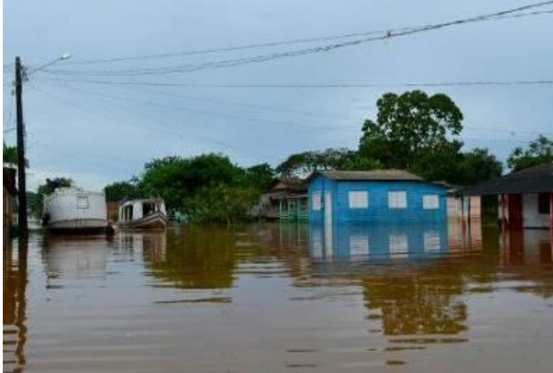
Figura 6: Casas foram invadidas pela água em Ferreira Gomes, no Amapá
