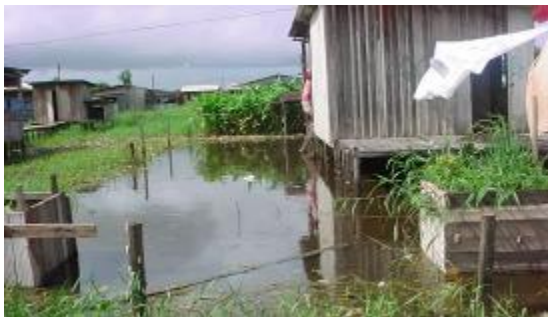
Figura 2. Habitações construídas em área de invasão na ressaca do Tacacá, bairro Zerão, Macapá.
