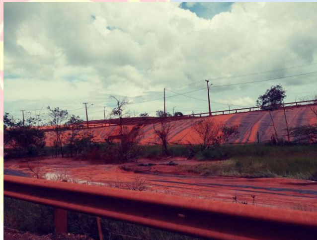
Figura 2. Índícios de transbordamento das bacias com rejeitos de bauxita da empresa Hydro Alunorte.
