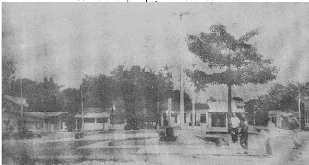
FIGURA 6: Construção da praça matriz do distrito de Benfica.
