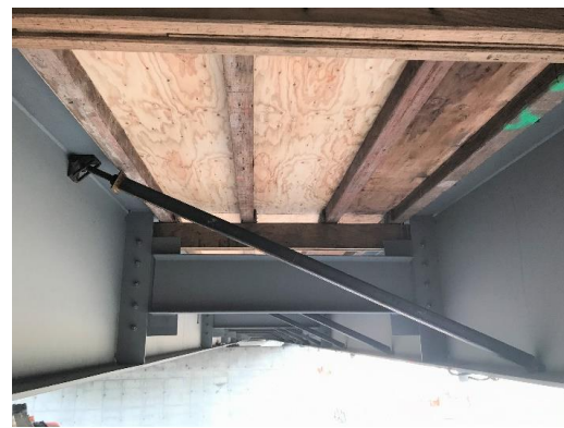
(d) Diaphragm with full-depth connecting plate
