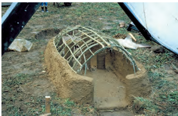
Fig. 5. Vidjeskelettet med påbegyndt lerkappe.
