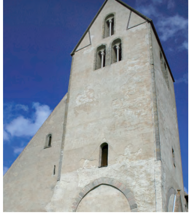
Fig. 12. Hamra kyrka. Tornets västra mur, exteriör. Foto: HR 2009.
