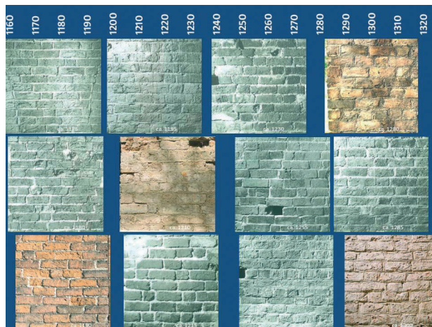
Fig. 11. Med dette fotomateriale kan hver én kvadratmeter af murværket undersøges og sammenlignes i strejflys. At få lyset til at falde ind i samme vinkel hver gang man står overfor et overbevisende eksempel, er svært at opnå. Muligvis står murværket klart på disse eksempler, hvordan den »skiftede« murværkskarakter i 1100-tallet står overfor den »stablede«, som blev så karakteristisk for 1200-tallet (Holst 1999).
