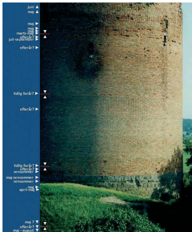
Fig. 8. Selvom mørtelprøver til pollenanalyser kun er udtaget enkelte steder, fremgår det, at de åbensynlige spring i mørtelkvaliteten hver svarer til en vinterpause (muligvis en afbrydelse over flere år). Hele tårnet synes at være bygget i løbet af fem byggefaser (Stolpe/Oder, Uckermark; jfr. Holst 2009).
