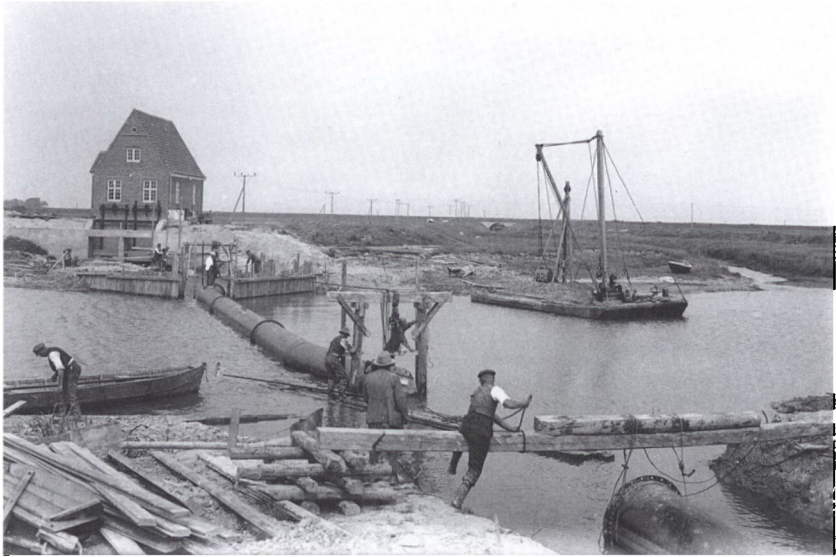
Etablering af pumpestation ved Højer i forbindelse med Tøndermarskens afvanding 1927-1933. Billedet er fra 1929. Foto: Fiskeri- og Søfartsmuseet i Esbjerg.
