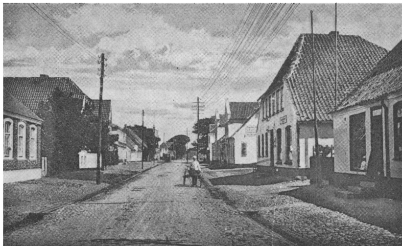
Et kig ned ad Storegade i Løgumkloster.
