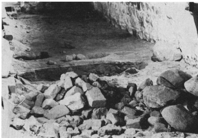
Fig. 2. Bække kirke. Nedgravning ved syddøren. I forgrunden det opgravede materiale.
