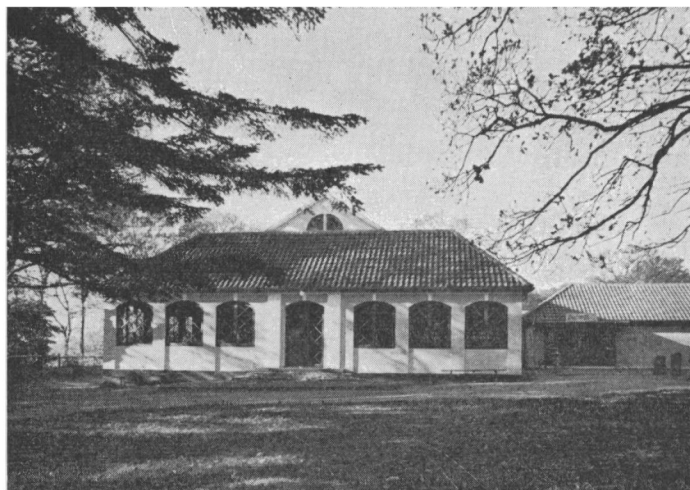
Pavillonnen, 1964. Set fra øst.
