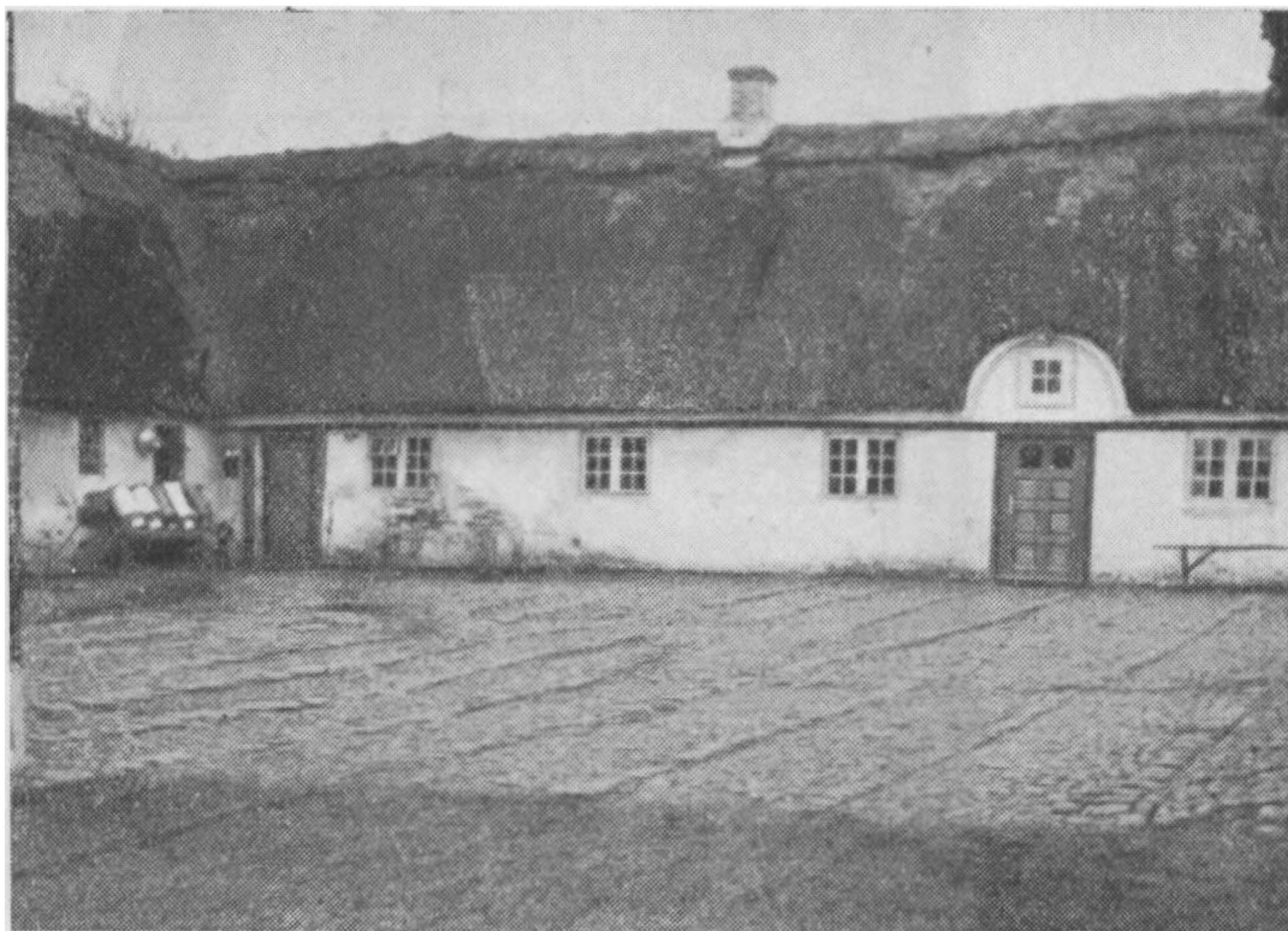
Kresten Bertelsens Gaard i Hunderup By og Sogn. Gaardspladsen er belagt med Kampesten, lagt Fagvis. Gaarden er bygget ca. 1780.
