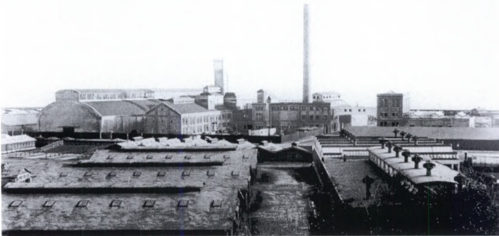
Århus Oliefabrik omkring 1920. Under navnet Århus Palmekernefabrik opførtes i begyndelsen af 1870'erne en række markante fabriksbygninger i byens sydlige udkant. Ret hurtigt herefter blev fabriken omgivet af erhvervs- og boligbyggeri. Senere udvidelser måtte derfor foregå andetsteds. Af hensyn hertil og de gældende sundheds- og bygningsvedtægter opførtes flere nye produktionsanlæg til oliefabrikken på Sydhavnen fra 1915 til 1918. På billedet ses disse kort efter indvielsen. Foto: Lokalthistorisk Samling, Århus
