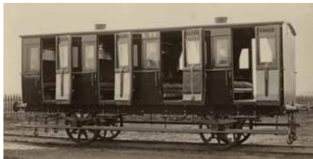
Leveringsfoto fra Hvide Mølle fra ca. 1871 af en personvogn Litra A, dvs. en kombineret 1. og 2. classes vogn, her med åbenstående døre. Det giver mulighed for at fornemme forskelle mellem de to klasser, bl.a. de mere luksuøse sæder på 1. klasse (Danmarks Jernbanemuseum).
