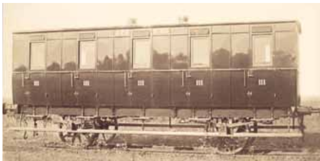
Foto af to-akslet tredjeklasses personvogn (Litra C) klar til levering fra fabrikken, 1872. Hvide Mølle skiftede både hænder og navn flere gange, inden den blev til den kendte vognfabrik Scandia (Danmarks Jernbanemuseum).
