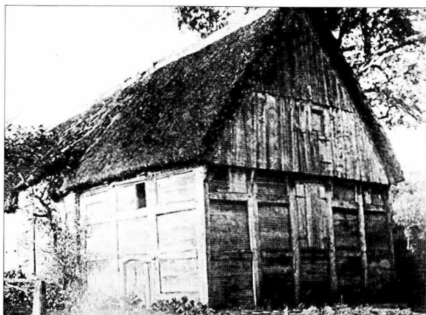
Fig. 6. Bulhuset på gården Østre Blåsholm i Løjt sogn, o. 1910, var et af de prægtigste træhuse i Østslesvig. Huset stammede fra første halvdel af 1600-tallet. I nederste stokværk var der kostald, ovenpå lå pisselen, der var prydet med malede blomsterdekorationer og indtil 1885 med blyindfattede vinduer. Nedrevet ca. 1920. Historiske Samlinger, Aabenraa.
