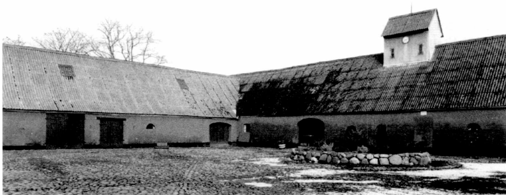
Fig. 14. Gårdspladsen på Terpsminde med udlængerne i grundmur fra 1845. Kornsilotårn fra omkring 1970. Foto: Mogens Bach 1999.
