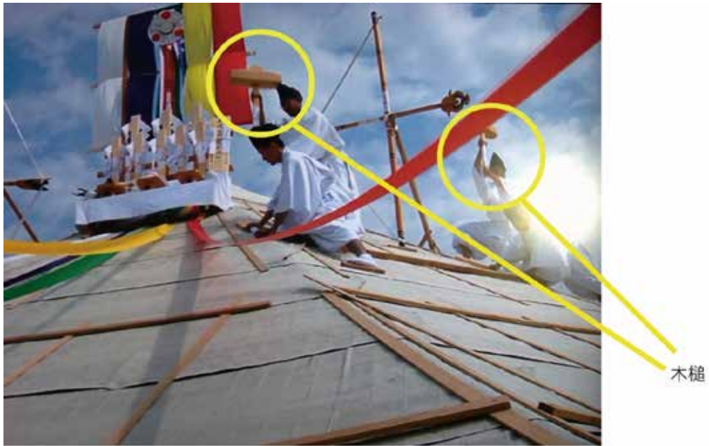
図5 上棟式における槌打ちの行い
