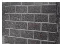
図4 在来の煉瓦壁の目地
