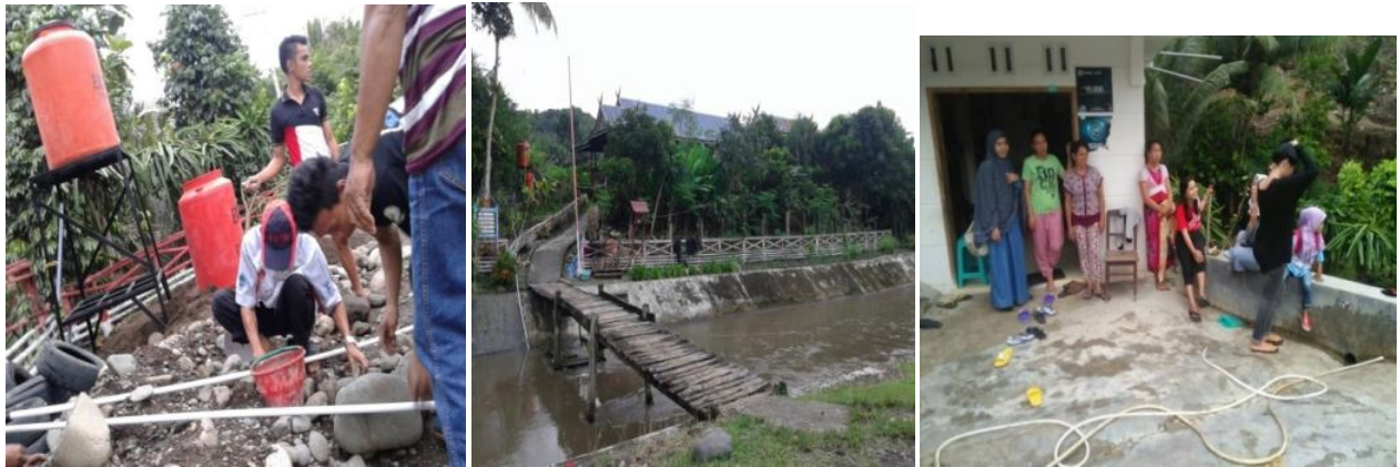
Gambar 6. Kegiatan pemasangan dan instalasi pipa dan Alat penjernihan air yang sudah terpasang di halaman rumah warga
