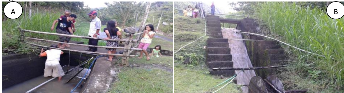
Gambar 7. Pemasangan saringan sampah (A) Bagian atas saluran (B) Bagian bawah saluran
