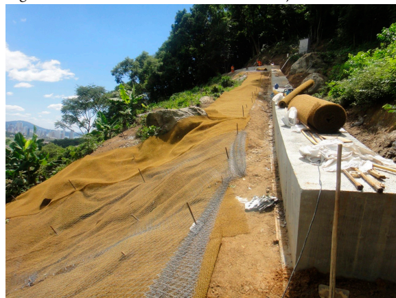
Figura 7 - Solução de contenção já executada.
