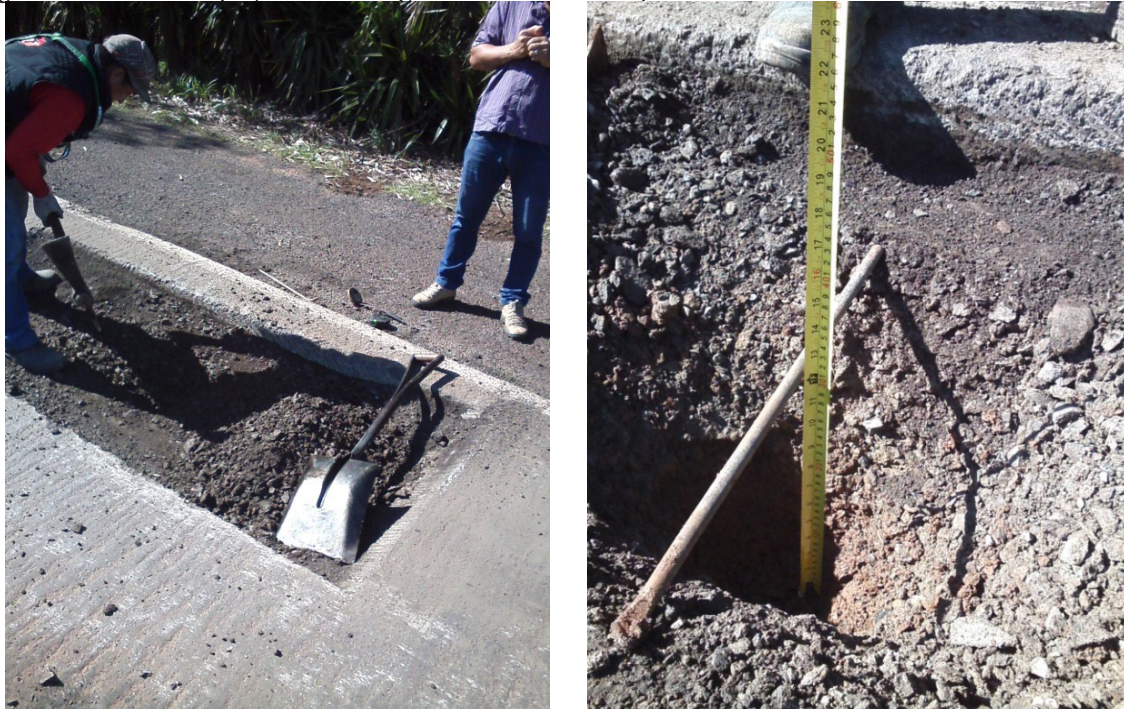
Figura 2 – Abertura poços de sondagem e medida das espessuras
