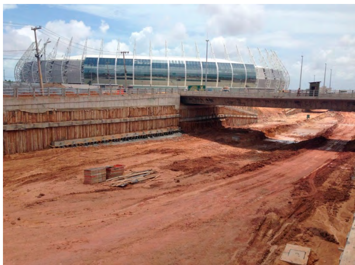
Figura 7. Vista da obra do túnel da Arena Castelão
