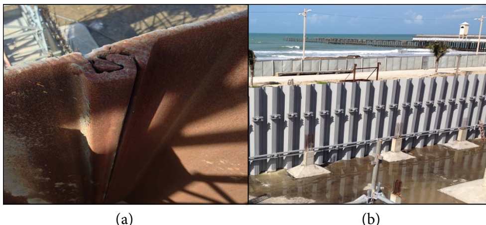
Figura 5. Estaca-prancha (a) intertravamento da estrutura; (b) componentes construtivos
