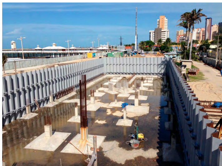
Figura 4. Vista da obra do Acquário
