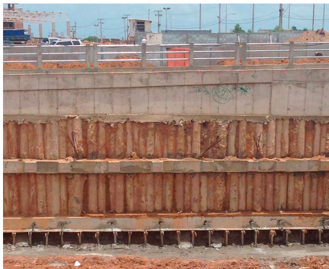
Figura 8. Estacas secantes no túnel da rotatória da Arena Castelão
